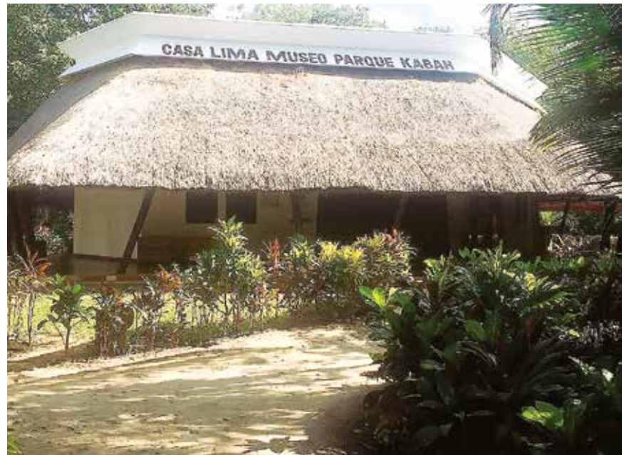
La casa en su nueva ubicación, el parque Kabah.
